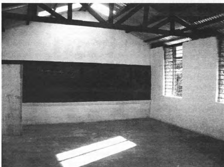
Ennen ja jälkeen. Olemme tehneet koululuokan katolle läpinäkyvän osan, joka tuo valoa liitutaululle.
