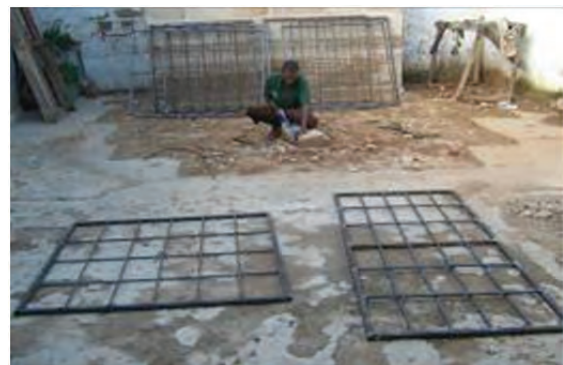
Teknikko työstämässä terästankoja ikkunoita ja pääporttia varten.
