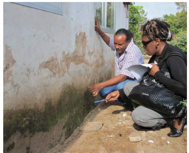
Ungon toimiston remontti oli tarpeen. Seinää tutkimassa Joseph Renaux ja Emma Simon Palonen.
